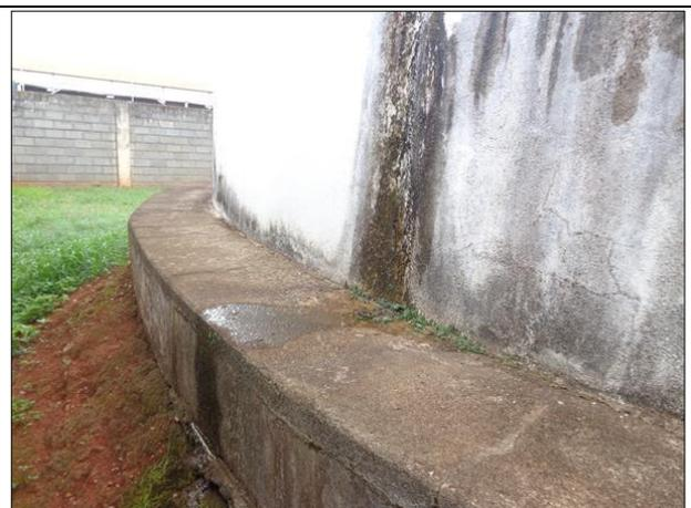
**Foto 22. Piso molhado próximo ao vazamento no R-34**
