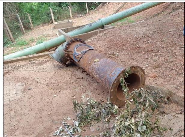
**Foto 12.** Tubulação removida para remoção da bomba
