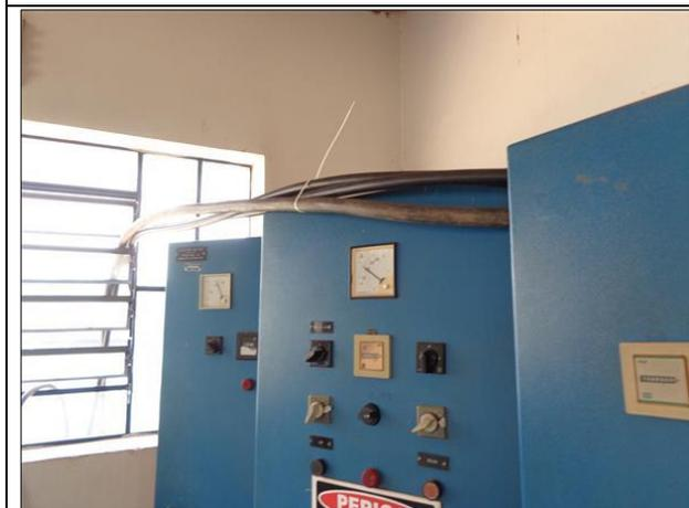
**Foto 15.** Ligação entre o gerador de energia e o quadro de comando do 3º CMB
