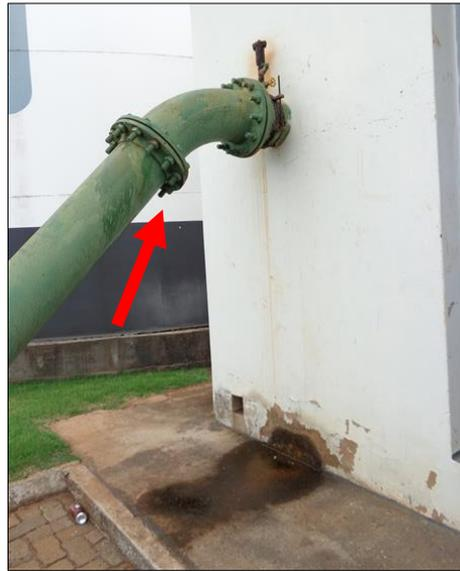
**Foto 18. Vazamento na conexão da tubulação**
