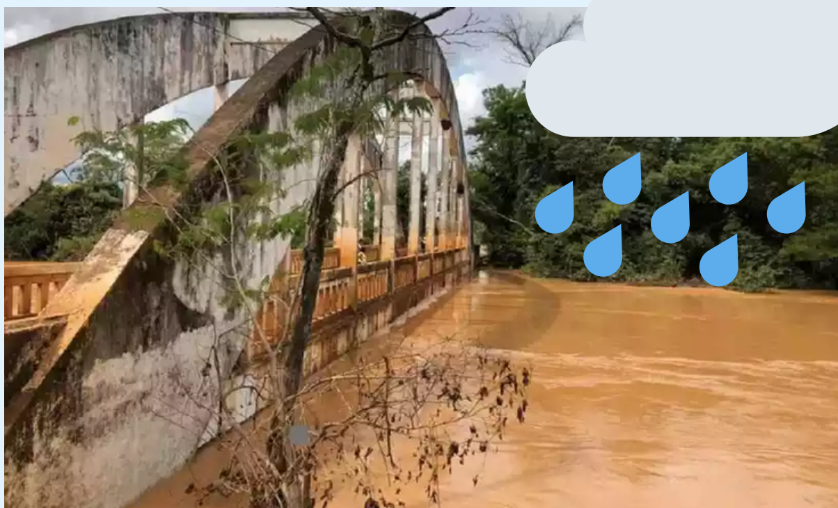
Registro de enchente na região da Ponte do Arco
